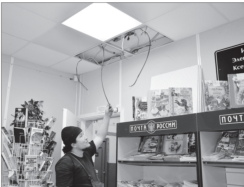
Замена электроосвещения на завершающем этапе.
