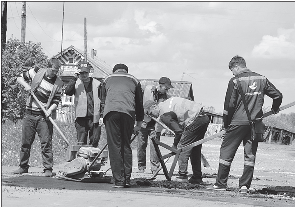
Ямочный ремонт к празднику
